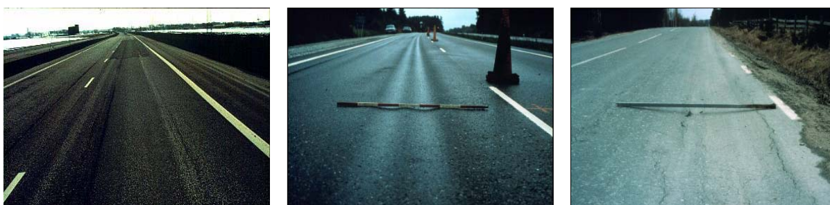
Figur A2. Vänster: Nötnings slitage. Mitten: deformationer i bitumenbundna lager orsakad av tung trafik. Höger: deformationer p.g.a. dålig bärighet.
