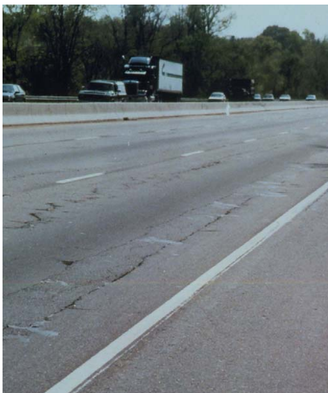
Figur 3. Längsgående ytsprickor (Rowe et al, 2001).
